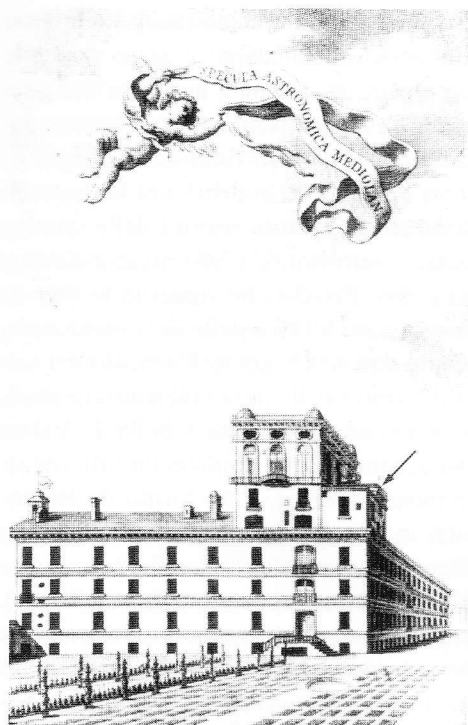
Fig. 6b. – La Specola di Brera nel 1776 vista dal lato Sud-Est e il Giardino del Collegio. È visibile sul lato Nord (indicata dalla freccia) la costruzione che proteggeva la scala interna a cinque rampe che dal piano superiore del Collegio portava al piano della camera A d'ingresso e proseguiva ancora al piano della Sala ottagonale. È pure visibile la scala esterna a due rampe che dal finestrone Est del Salone portava al piano superiore d'ingresso nel terrazzo (lato Nord) (cfr. Ephemerides Astronomicae Anni 1777, Mediolani, 1776 ).
