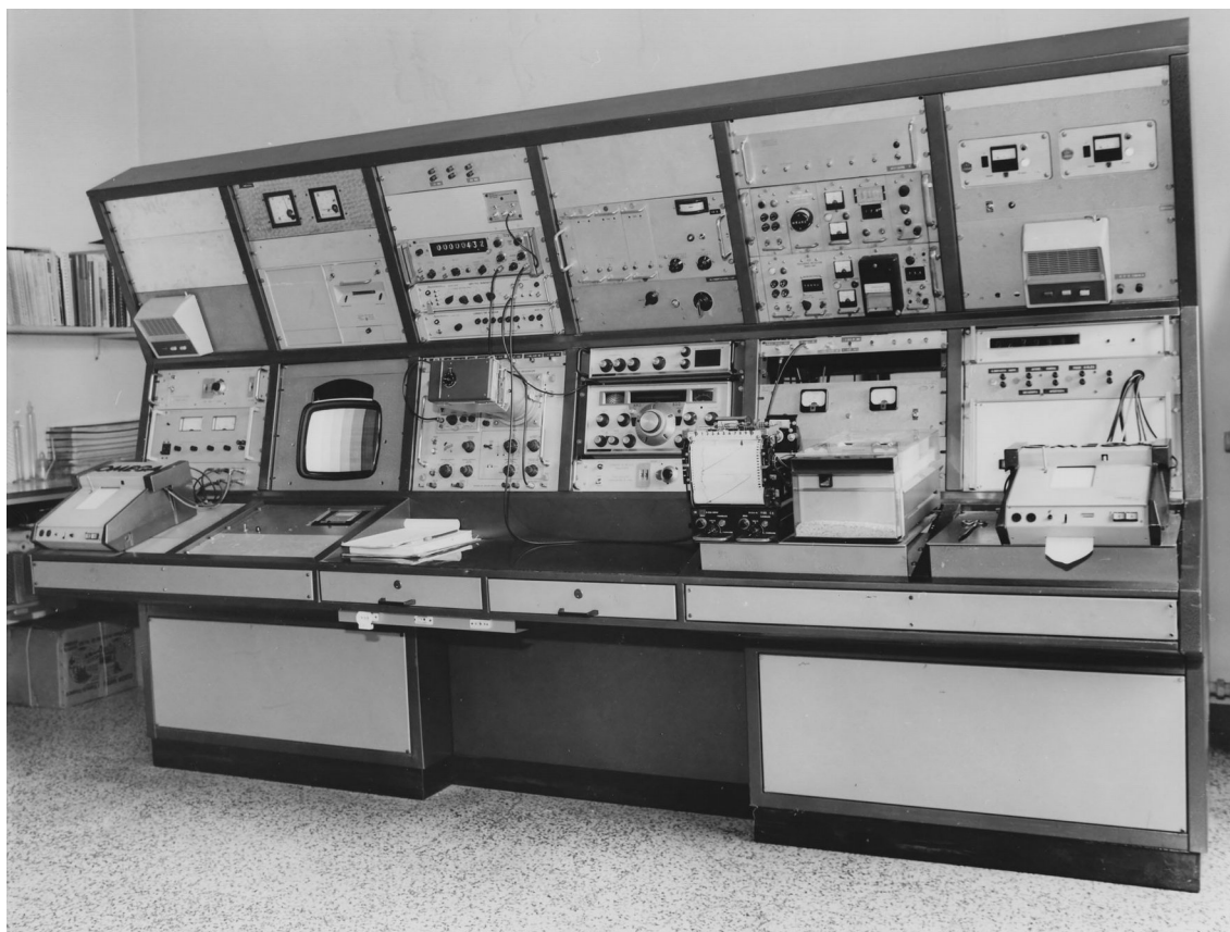
Figura 19: Il quadro di controllo della stazione del tempo nella sede di Merate agli inizi degli anni '70. La strumentazione gestiva gli orologi (alloggiati in una stanza termostata separata), i trasmettitori radio che diffondevano i segnali orari, e i ricevitori che permettevano il confronto con i segnali di sincronizzazione provenienti da altri istituti.
