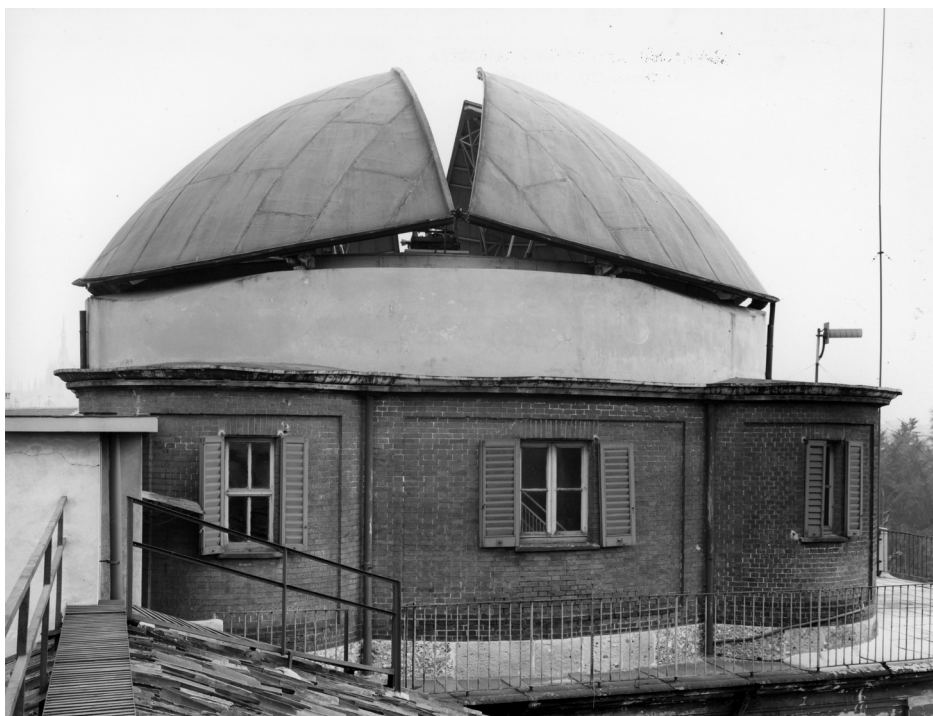
Figura 31: La nuova “cupola a fiore” costruita nel 1957 nel sito dove precedentemente sorgeva la cupola del Merz-Repsold a Brera, con i quattro “petali” che costituiscono la copertura in posizione di apertura.
