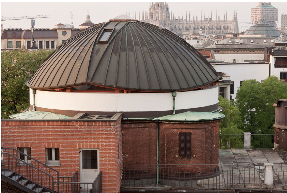
Figura 35: La cupola a fiore dopo la ristrutturazione del 1995; si notino gli inserti (dotati di lucernari) che chiudono lo spazio a forma di croce lasciato libero dalle quattro piastre di copertura, bloccate in posizione semiaperta.
