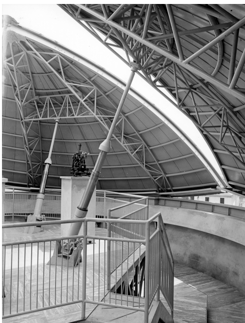
Figura 33: Il meccanismo di apertura della cupola a fiore visto dall'interno, con due dei quattro cilindri idraulici che sollevano le piastre di copertura.
