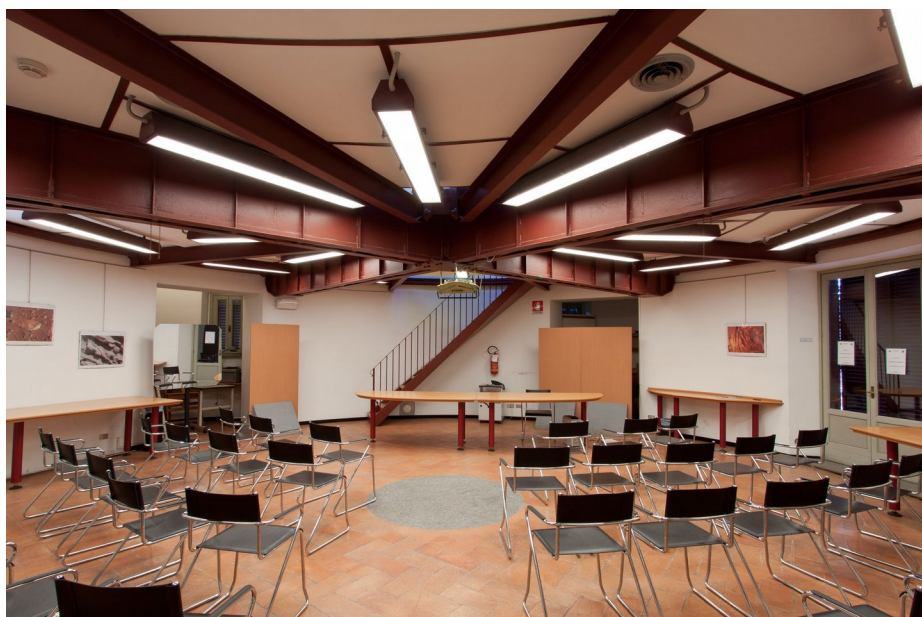
Figura 34: Un'immagine recente (2010) dell'interno della cupola a fiore, dopo la sua ristrutturazione in sala per conferenze. Si noti, al centro del pavimento, il disco di pietra su cui era appoggiata la colonna del rifrattore Merz-Repsold. Le putrelle d'acciaio che sostengono il soffitto risalgono alla ristrutturazione effettuata nel 1957, quando al piano superiore erano installati gli strumenti dei passaggi.
