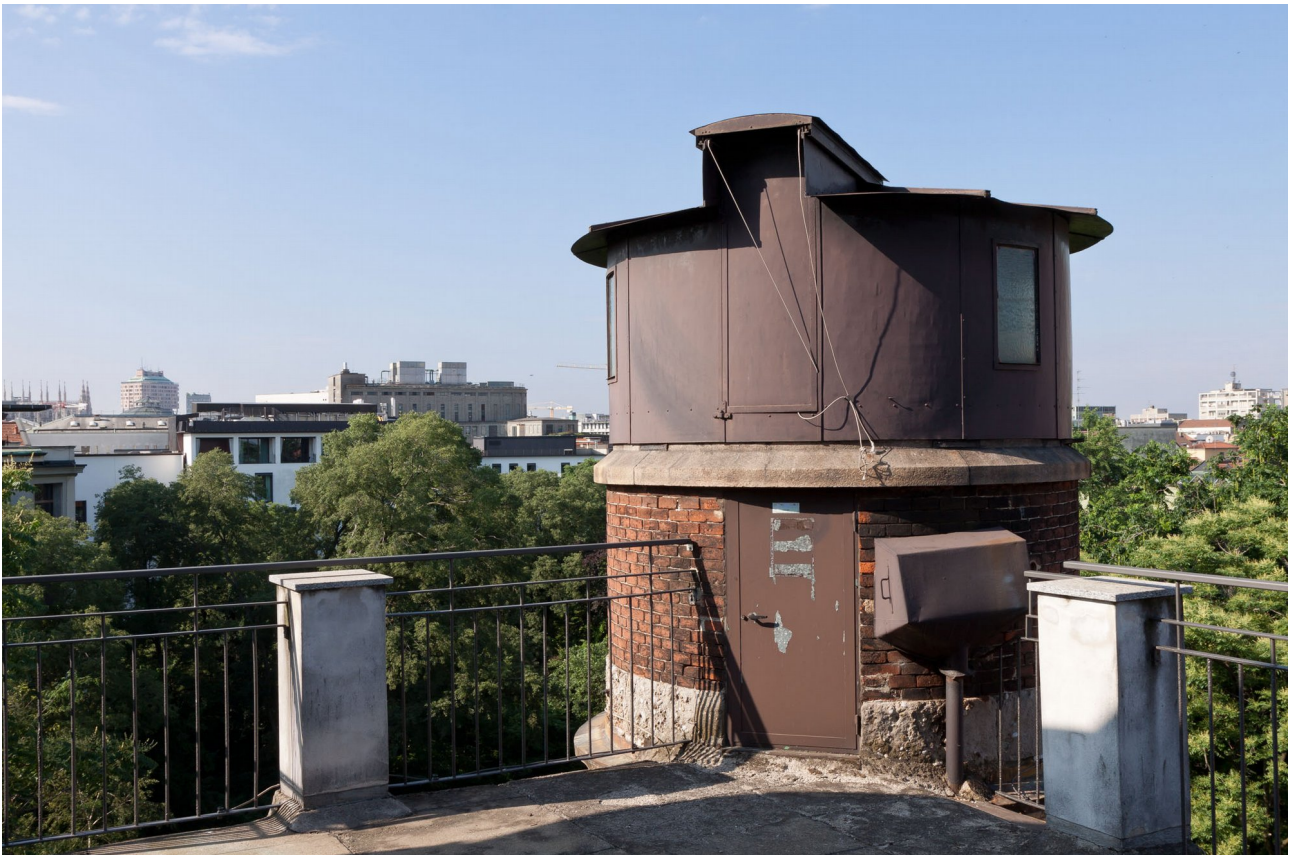
Figura 22: Il cupolino situato sulla sommità della torre occidentale della facciata sud dell'Osservatorio Astronomico di Brera, dove è installato il rifrattore Merz-Cavignato.
