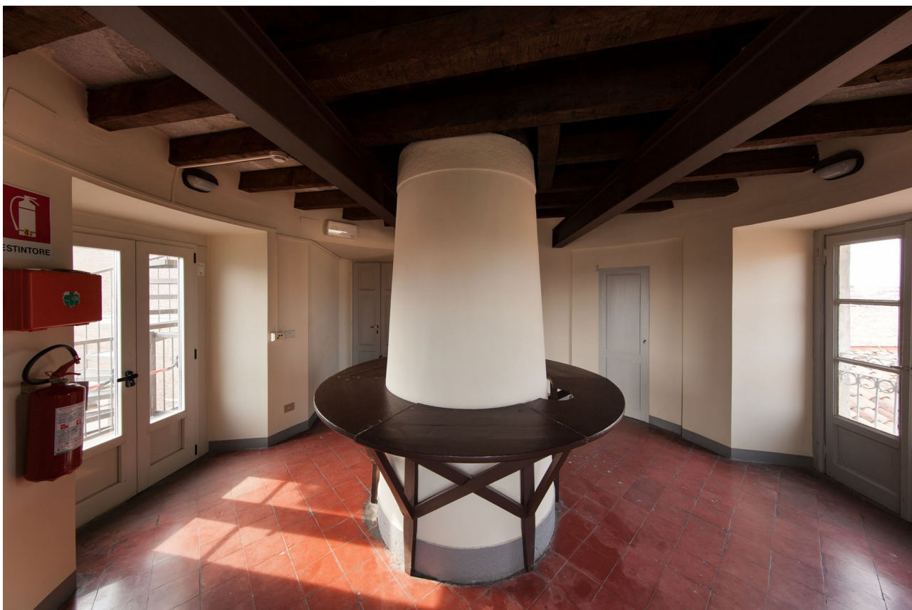
Figura 12: Veduta del locale sottostante alla cupola Schiaparelli, con la colonna di pietra che regge la montatura del telescopio Merz 8’.
