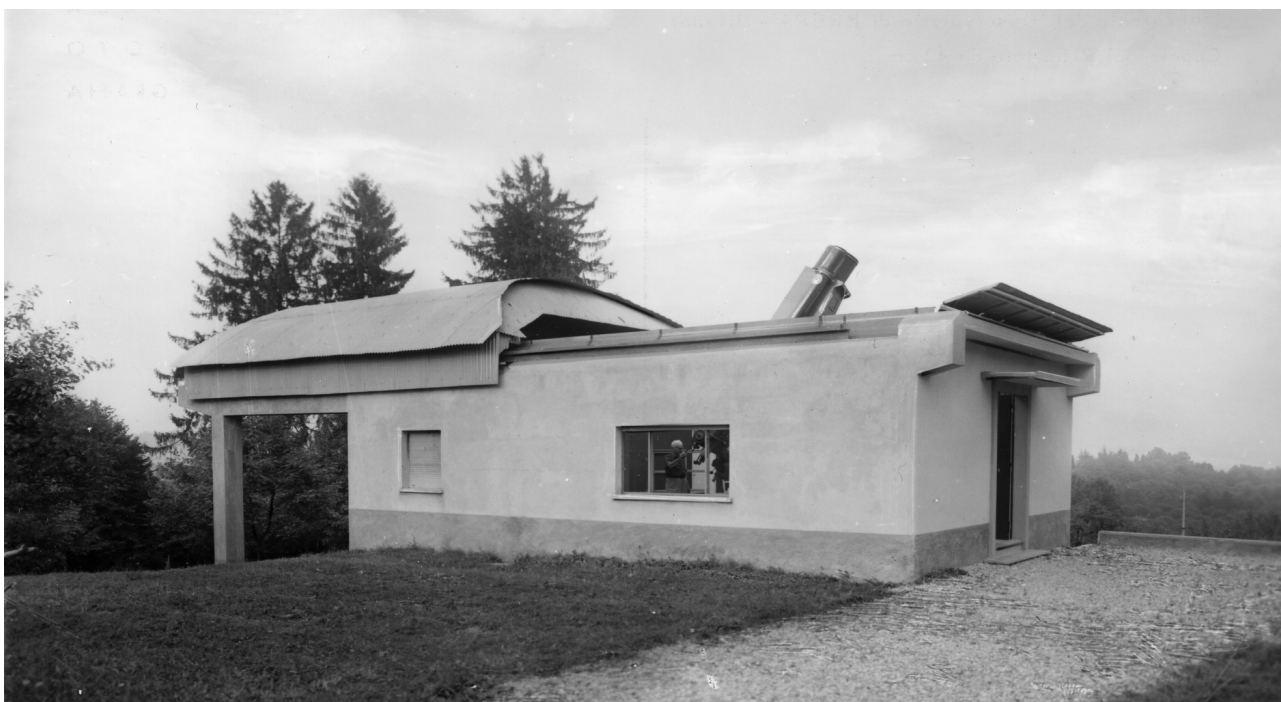
Figura 38: L'edificio dove fu installato il catadiottrico Galileo, con il tetto scorrevole in posizione di apertura.
