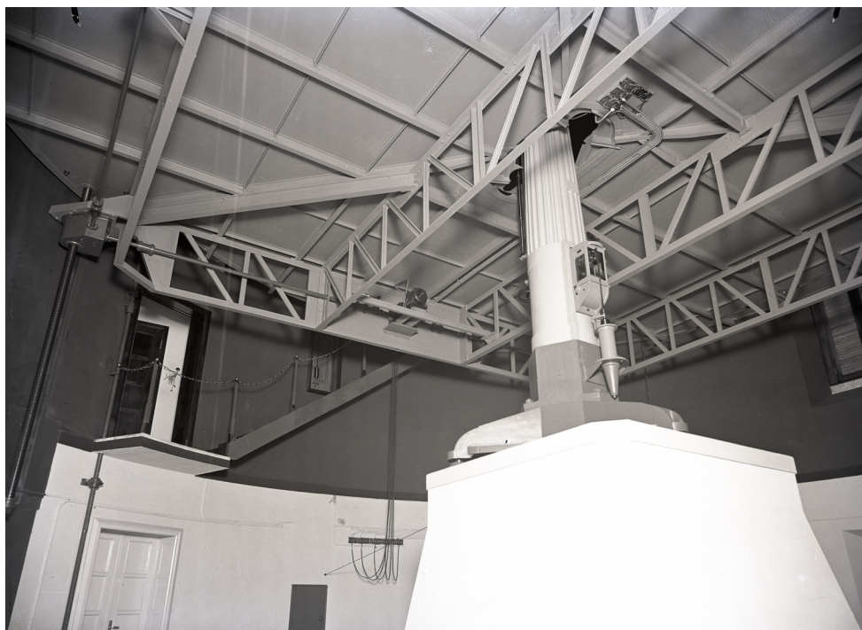
Figura 29: Il pavimento mobile della cupola del Merz-Repsold a Merate, visto dal basso.
