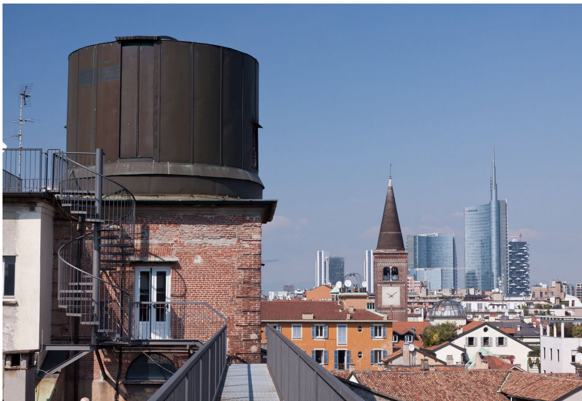
Figura 11: Veduta attuale (marzo 2014) della cupola Schiaparelli dal lato sud, dalla passerella che la collega alla cupola a fiore: la cupola metallica girevole a forma di cilindro è sostenuta da un locale in muratura (in mattoni rossi) che contiene il pilastro di pietra che sorregge la montatura del telescopio.
