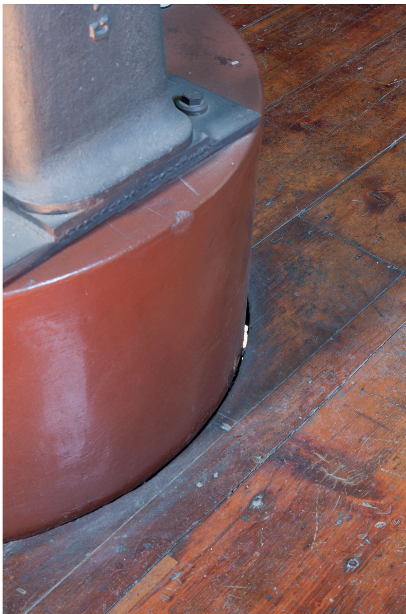
Figura 13: La fessura tra il tavolato di legno che costituisce il pavimento della cupola Schiaparelli e la montatura del telescopio.
